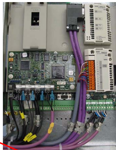
用金属夹连接电缆屏蔽到安装板的金属表面
